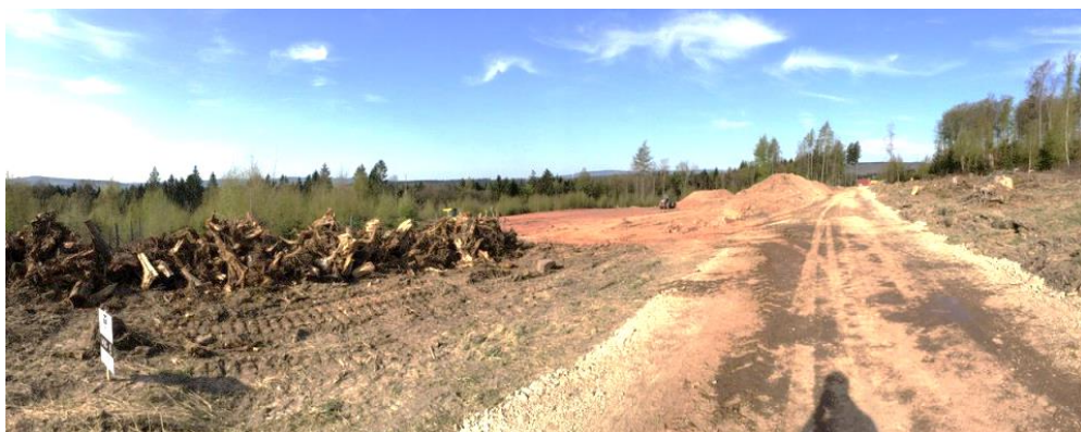
Abbildung 24: Windkraftbaustelle im Naturpark Kaufunger Wald (Hessen, 2016)
